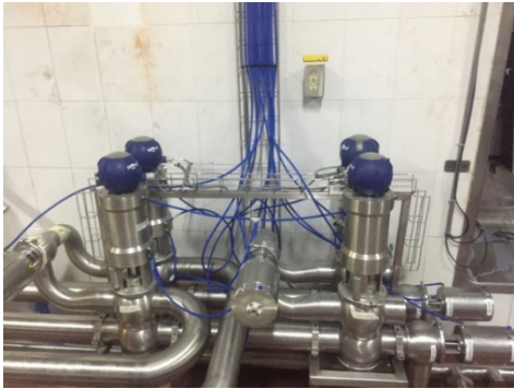
Figura 5: Válvulas Mixproof
